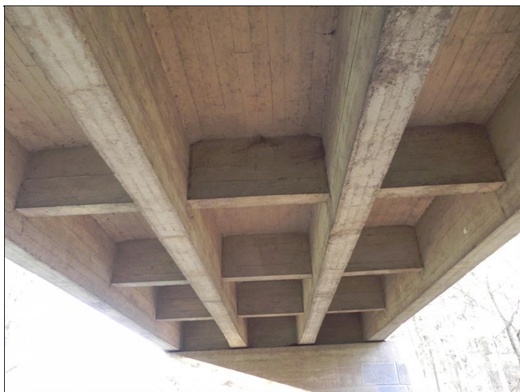
Podhled na nosnou konstrukci - pole č. 1
